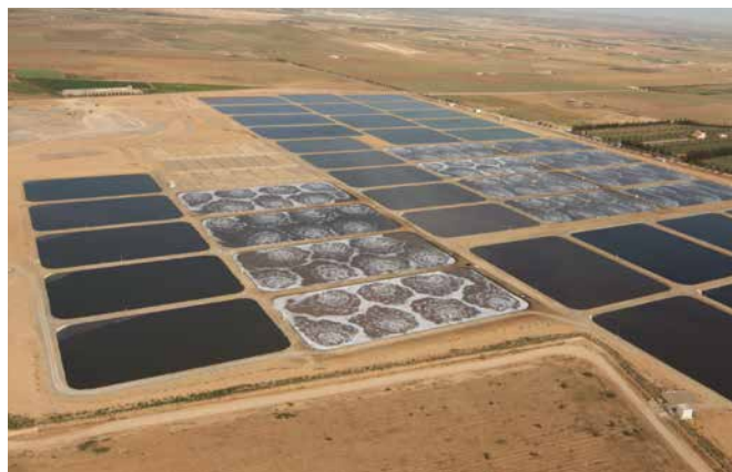
Sistema de lagoa de tratamento de efluentes aerada com aeradores OxyStar® (Marrocos)
