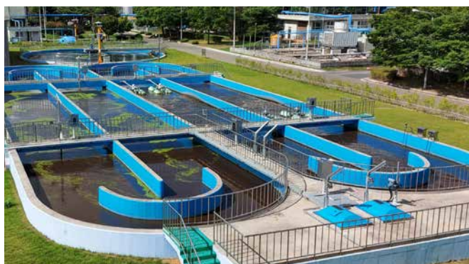
Canal de oxidação de uma Estação de Tratamento de Esgoto (ETE) municipal (Coreia)
