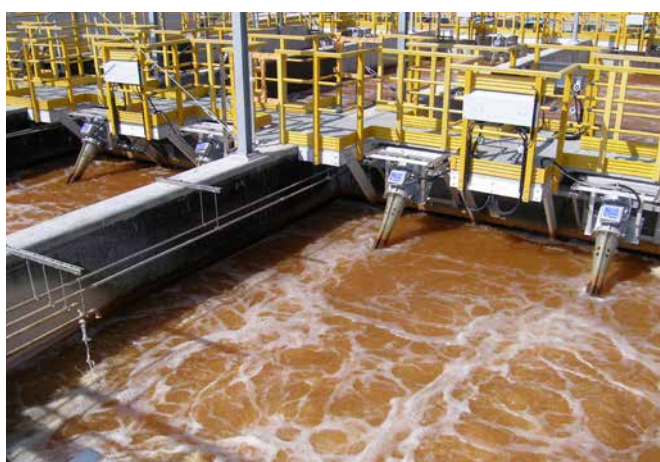
Uma aplicação especial dos aeradores OxyStar® é a oxidação de ferro ferroso presente em águas de mineração
