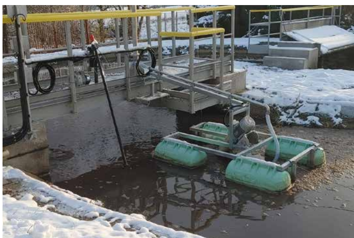
Aerador DualStar sobre flutuadores em uma estação de tratamento de esgoto municipal (República Tcheca)
