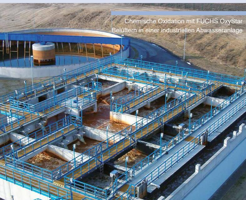
Chemische Oxidation mit FUCHS OxyStar Belüftern in einer industriellen Abwasseranlage
