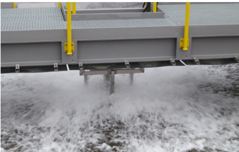
Aireador AeroStar con soporte de montaje a puente
