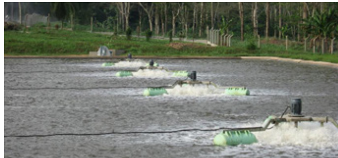
Tratamiento de aguas residuales resultado del procesamiento de látex y caucho
