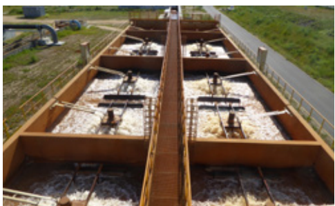
Aireador AeroStar en un tanque de equalización de una cervecería
