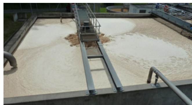
Tratamiento de aguas residuales de la industria química
