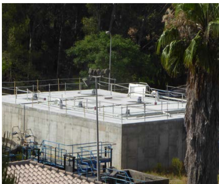
Aumento del rendimiento de una planta de tratamiento de aguas residuales municipales (España)
