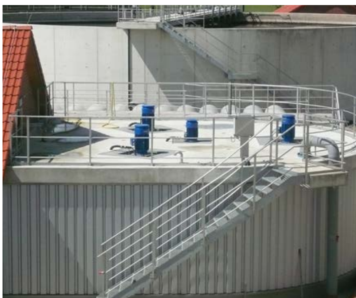
Digestión aeróbica para aliviar el proceso de lodos activados (Alemania)
