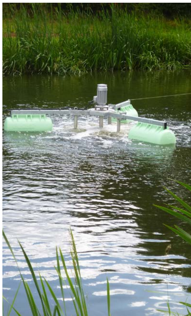
Aireador de embalse Centrox de bajo mantenimiento en una laguna de aguas residuales
