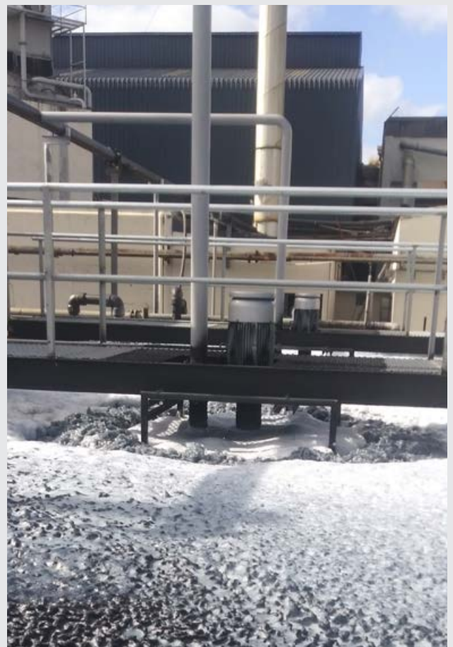
Inyector de gas Centrox CX-G sobre un puente de máquina
