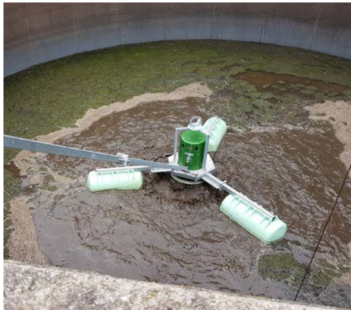
Aireador Centrox con rompe-espuma CX-S sobre flotadores
