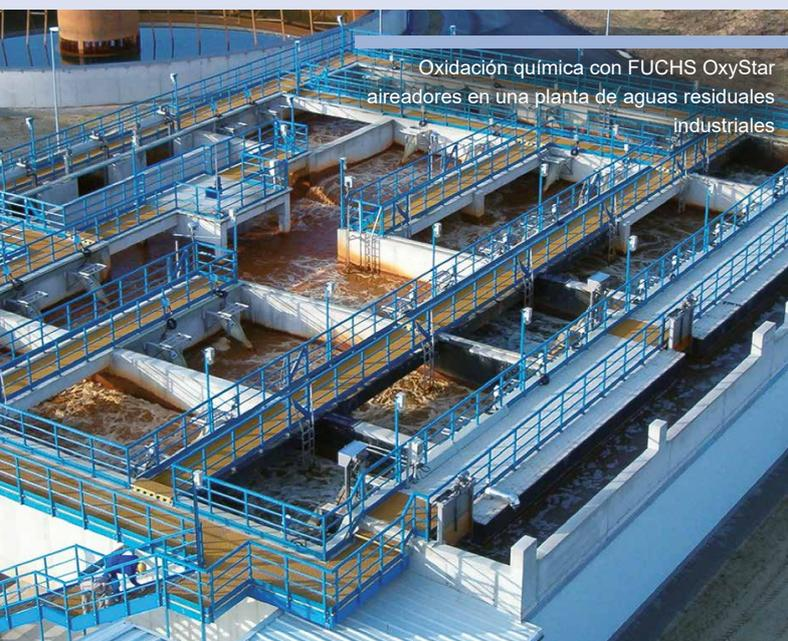
Oxidación química con FUCHS OxyStar aireadores en una planta de aguas residuales industriales
