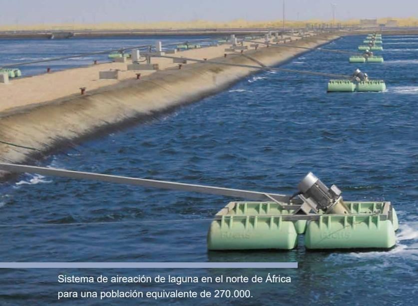
Sistema de aireación de laguna en el norte de África para una población equivalente de 270.000.
