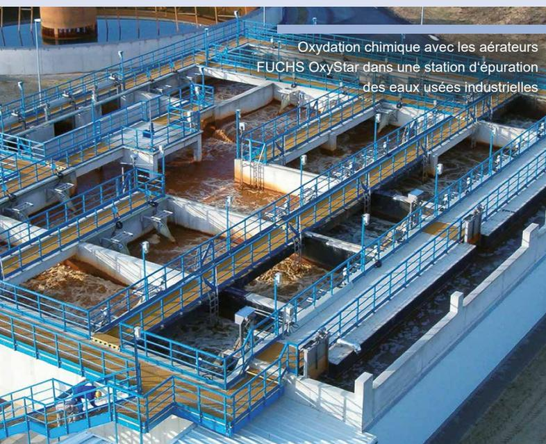
Oxydation chimique avec les aérateurs FUCHS OxyStar dans une station d'épuration des eaux usées industrielles
