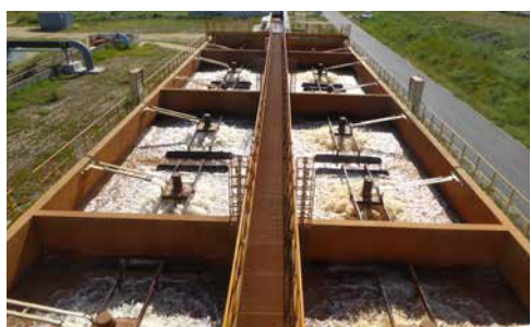
Aérateur AeroStar pour le stripping du \text{CO}_2
