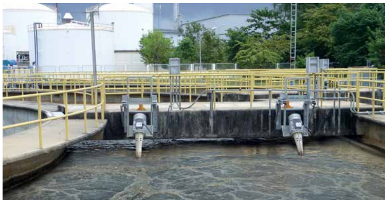
Aérateurs OxyStar® avec support de montage dans un bassin à boues activées d'une station d'épuration eaux usées industrielles (Thailand)
