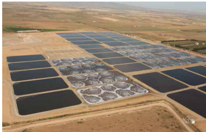
Lagunage aéré avec l'aérateur OxyStar® (Maroc)
