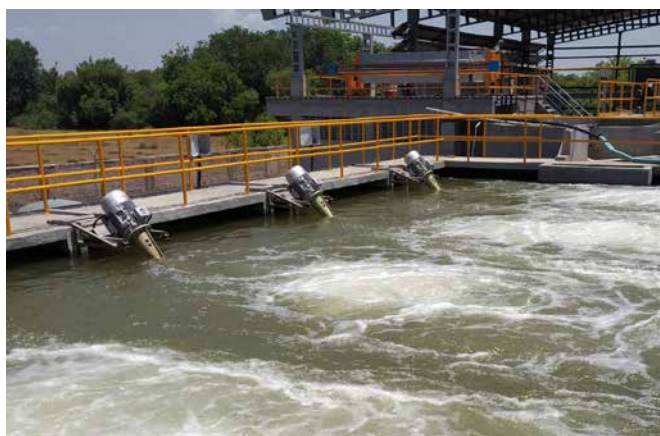
Une application spéciale des aérateurs FUCHS OxyStar® est leur utilisation dans le traitement des eaux minières pour oxyder le fer existant
