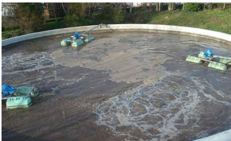
Bassin d'homogénéisation avec aérateurs OxyStar® (France)
