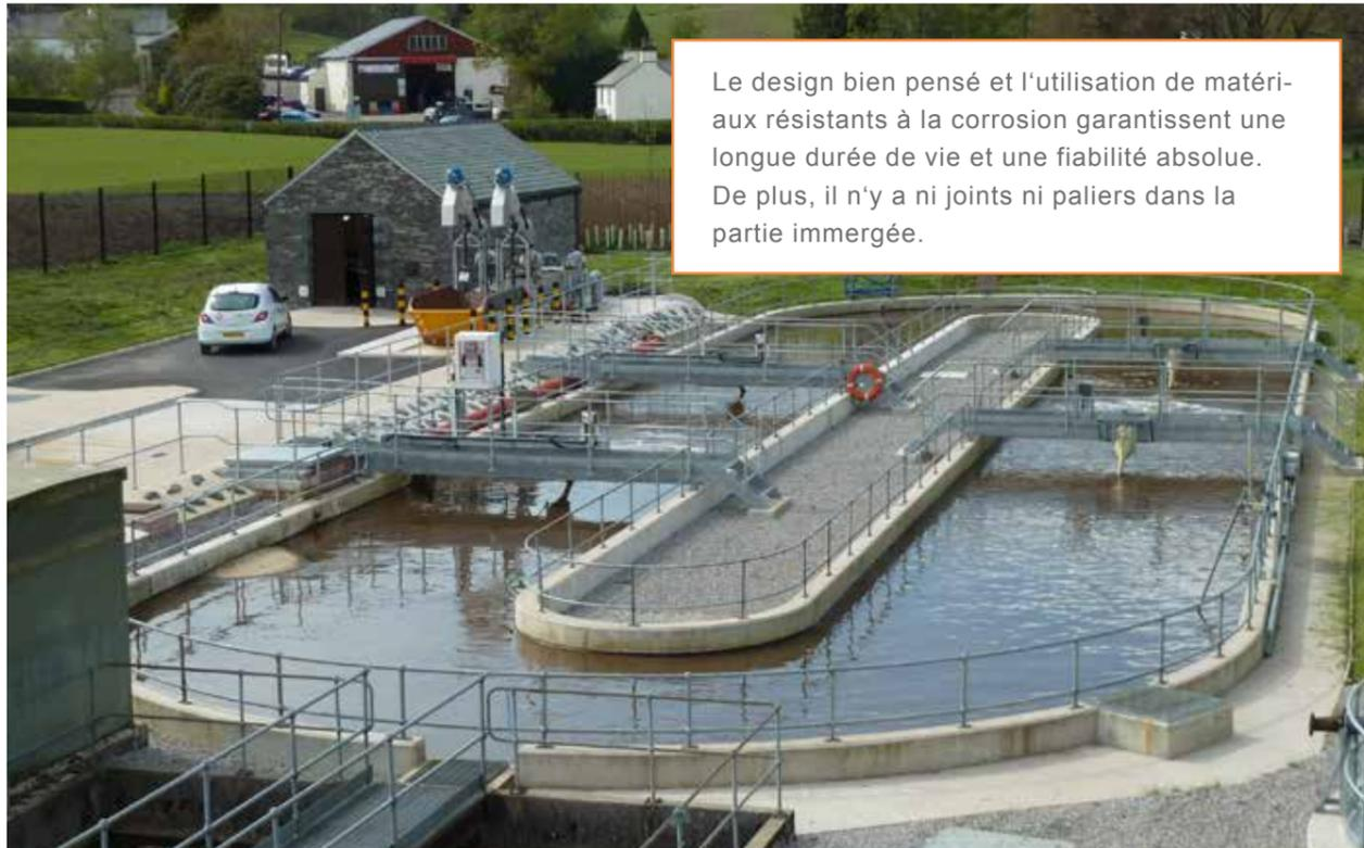
Aérateurs FUCHS dans le chenal d'oxydation d'une station d'épuration urbaine (Royaume-Uni)
