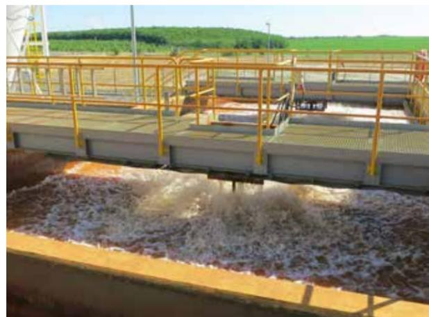
Aérateur AeroStar pour la désorption du CO<sub>2</sub> dans l'eau minière
