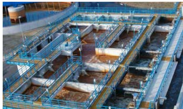
Aérateurs OxyStar® pour l'oxydation des eaux de mine
