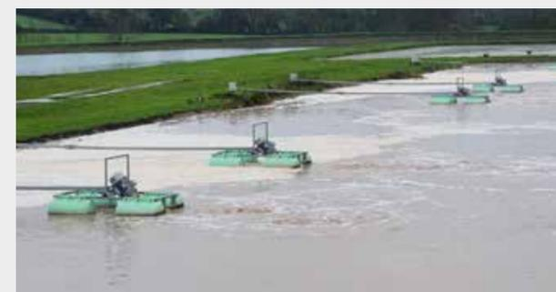
Aérateur FUCHS dans une station d'épuration d'une laiterie (France)
