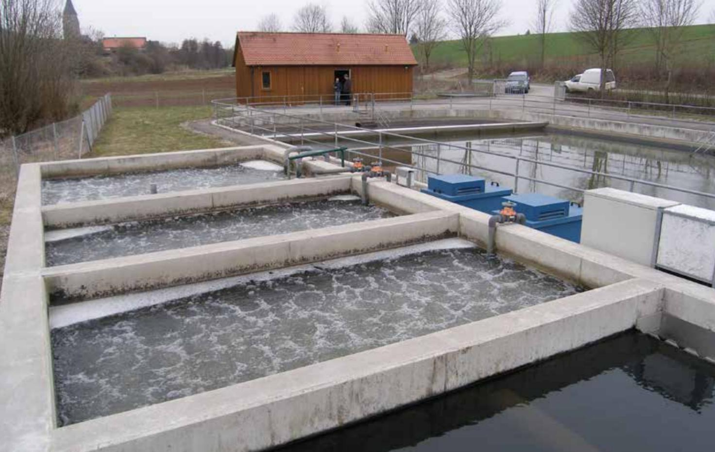
Installation FUCHS à lit fixe pour la dégradation du carbone et la nitrification (Allemagne)
