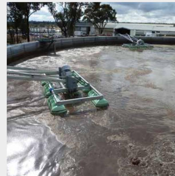
Aérateurs FUCHS flottants dans le bassin d'aération d'un abattoir (Australie)
