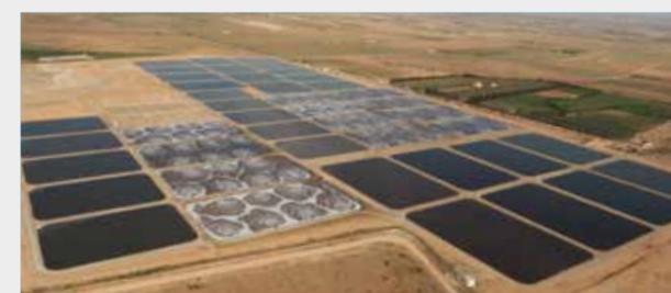
Géante station d'épuration par lagunage aéré avec Aérateurs FUCHS (Maroc)
