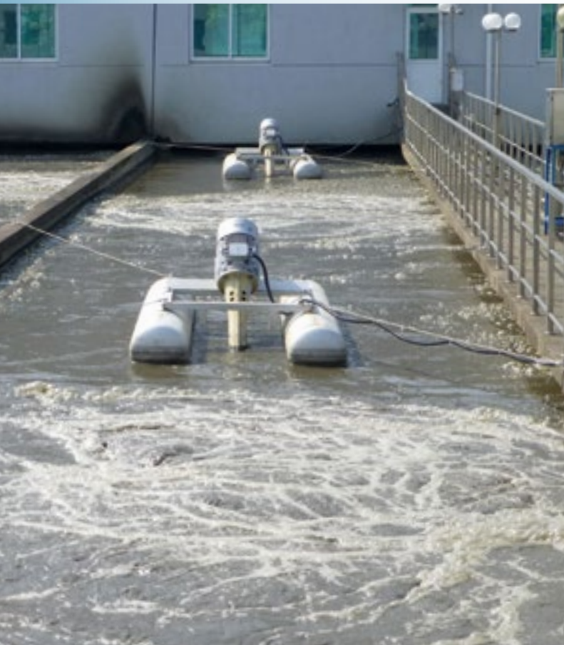
漂浮式富克斯曝气机用于氧化沟
