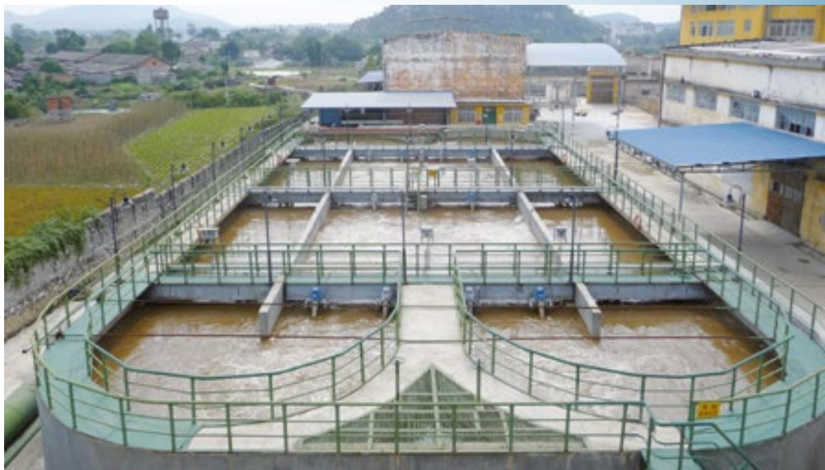
富克斯 OxyStar 曝气机用于广西省 某糖厂的氧化沟工艺
