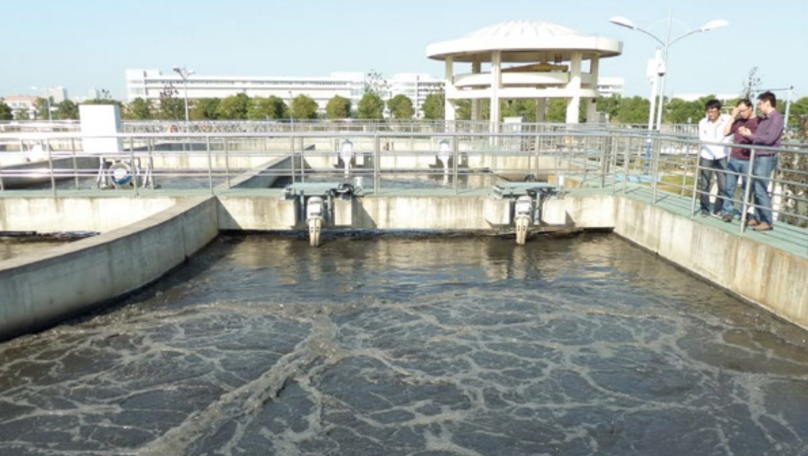
富克斯 OxyStar 曝气机用于 污水池的充氧和搅拌（苏州）
