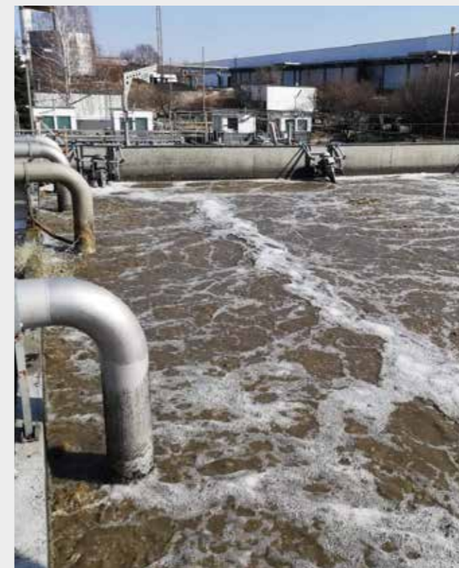
Aireadores FUCHS complementan fácilmente la aireación por aire comprimido existente (Bulgaria)
