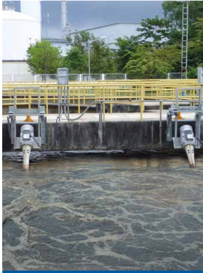
Aireadores FUCHS en una aplicación industrial (Tailandia)
