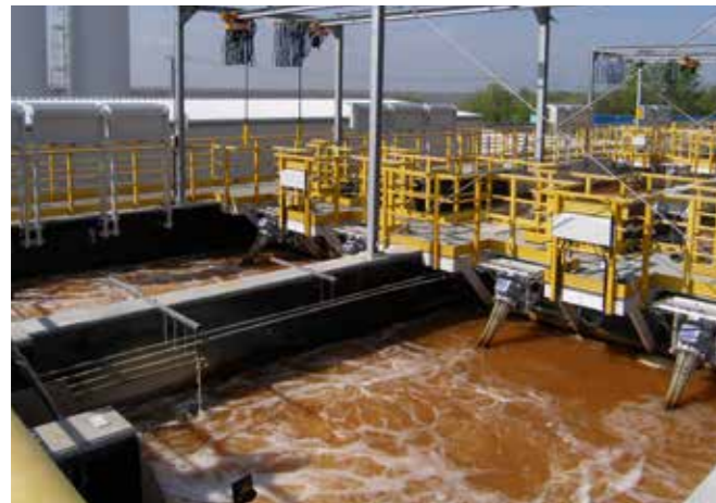
Aplicación intensiva con Aireadores OxyStar® (Alemania)
