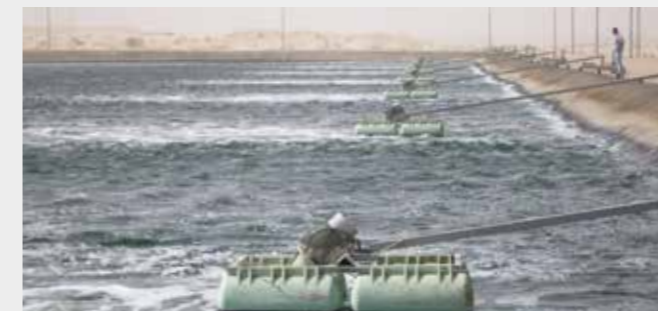
Transferencia eficiente de oxígeno con aireadores FUCHS OxyStar® (Argelia)
