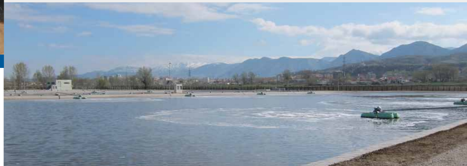
Sistema de lagunas aireadas de aguas residuales para P.E. 70.000 (Albania)
