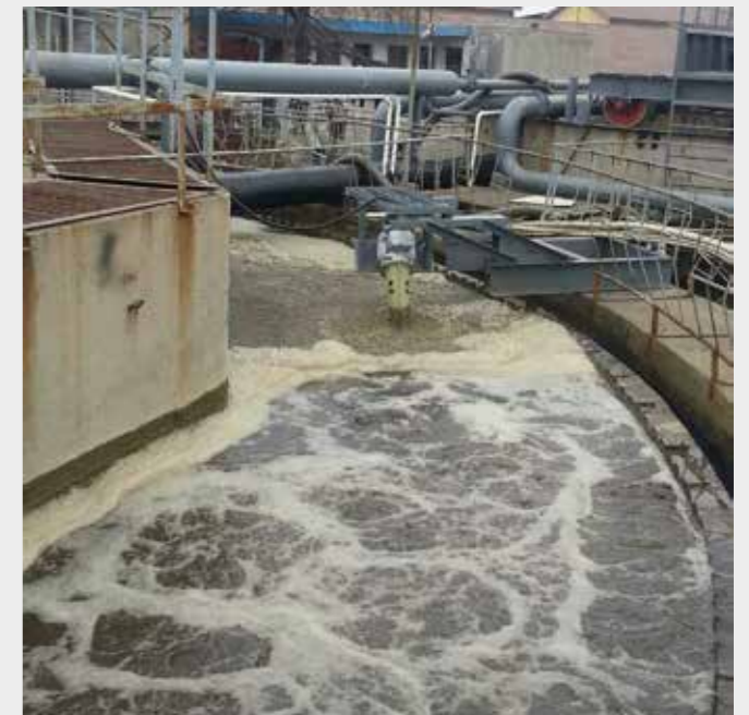
Aireadores FUCHS para aireación y mezcla de aguas residuales de la industria textil (China)
