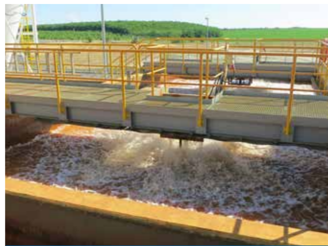
Aireadores AeroStar para la desorción de CO 2 en agua de mina (Alemania)
