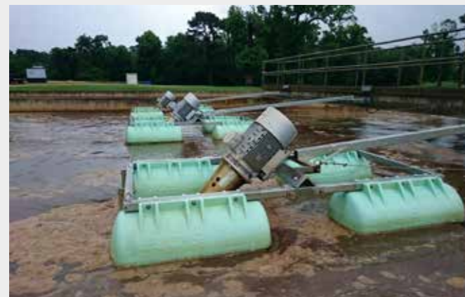
Aireadores FUCHS sustituyen con éxito antiguos aireadores de cepillo flotante (EE.UU.)
