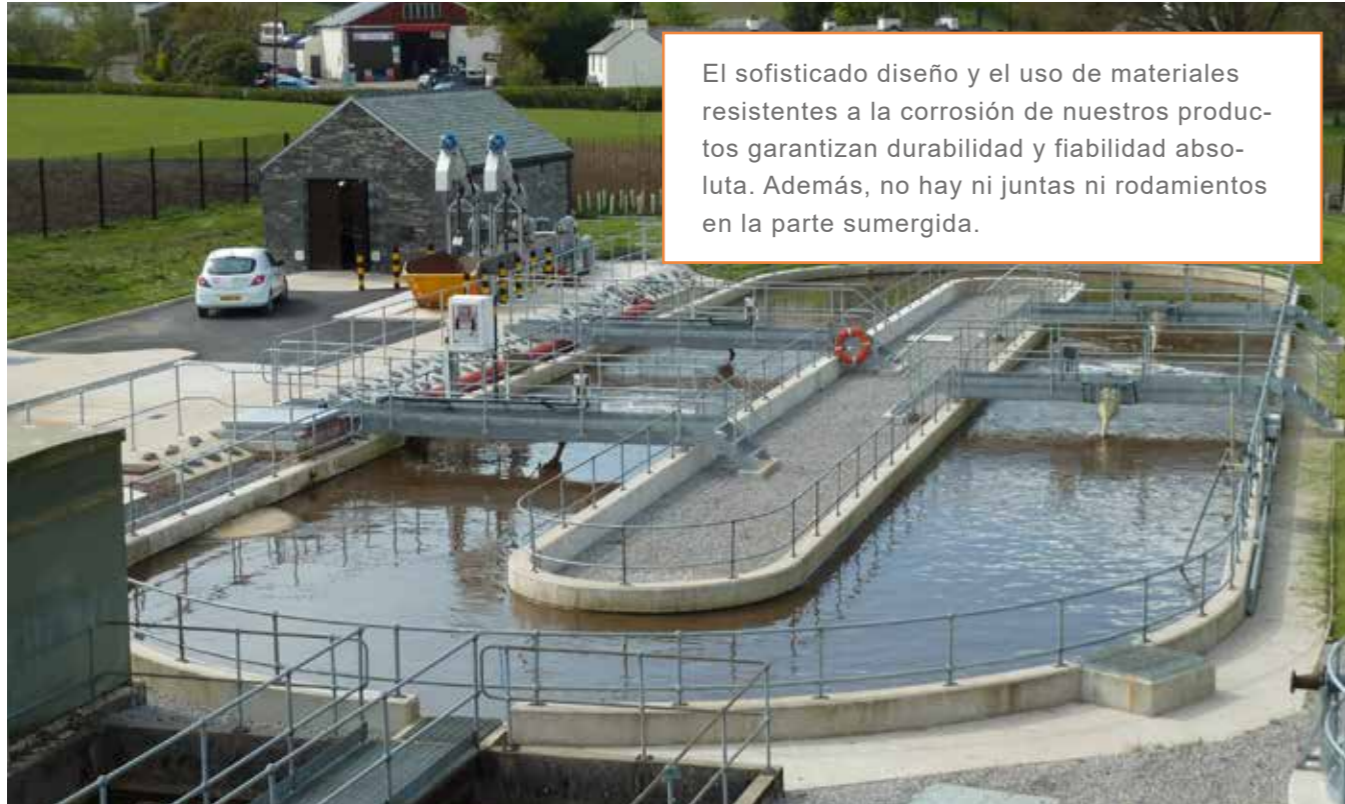
Aireadores FUCHS en la zanja de oxidación de una PTAR municipal (Reino Unido)
