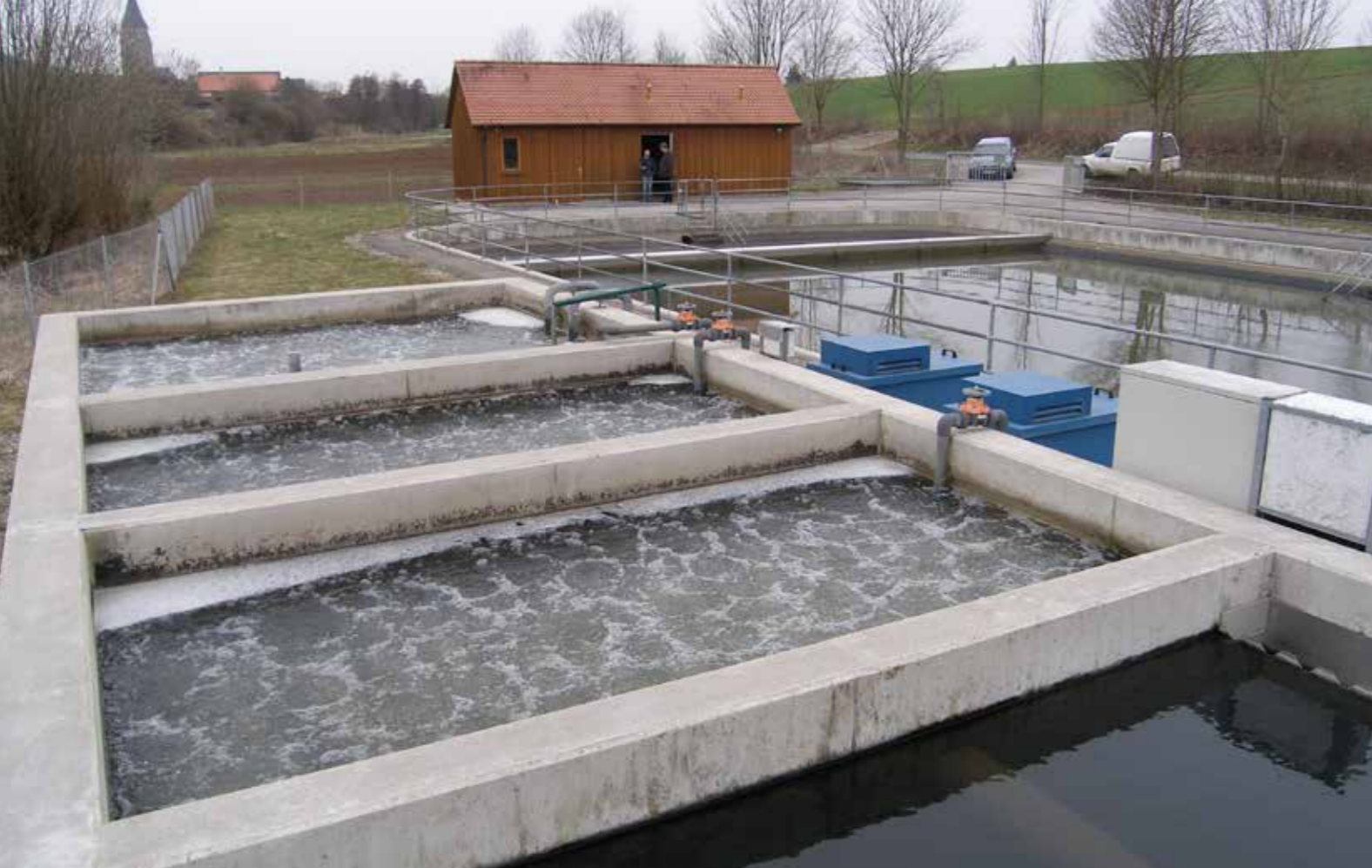
Sistema de lecho fijo FUCHS para eliminación de carbono y nitrificación (Alemania)
