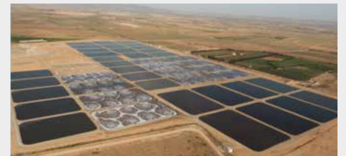
Extenso sistema de lagunas aireadas para aguas residuales con aireadores FUCHS (Marruecos)
