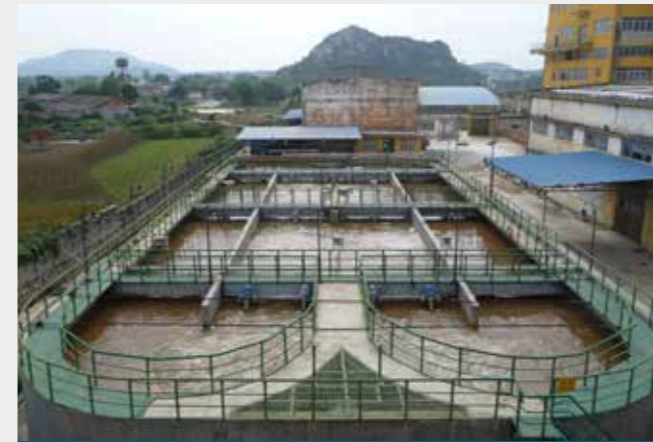
Aireadores FUCHS en un tanque de lodos activados de una azucarera (China)
