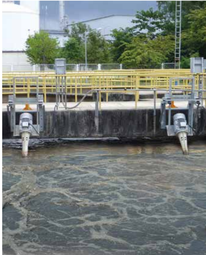
FUCHS Belüfter im Belebungsbecken einer Industriekläranlage
