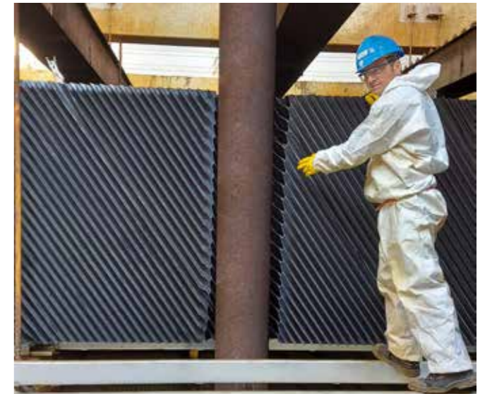
FUCHS führt Installationsarbeiten vor Ort durch oder bietet die Überwachung der Montagearbeiten durch den Kunden an
