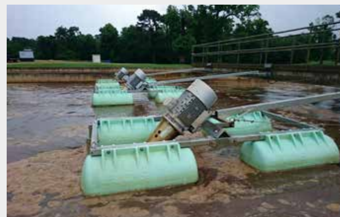
Ersatz von alten störanfälligen Walzen durch FUCHS Belüfter
