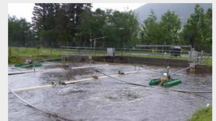
FUCHS Mietbelüfter zum Ausgleich eines Sauerstoffdefizits
