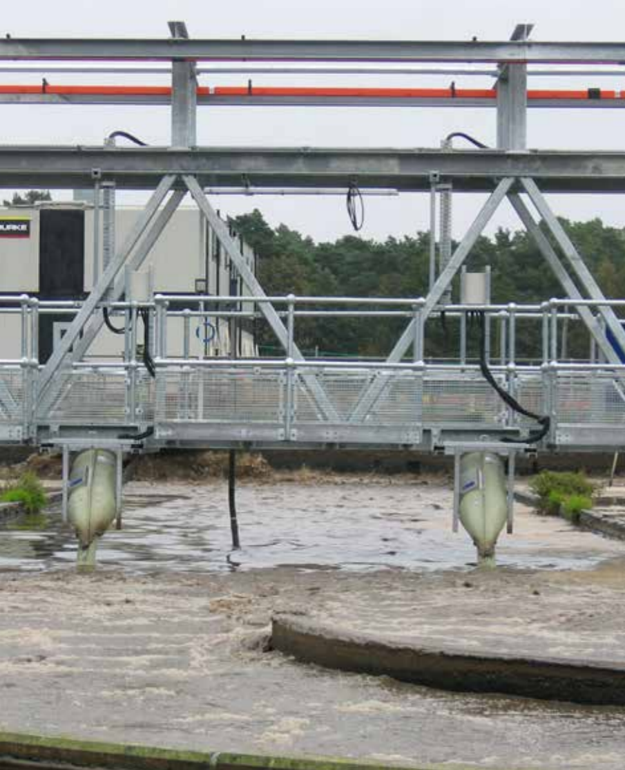
Ergänzung der Belüftung in einem Oxidationsgraben
