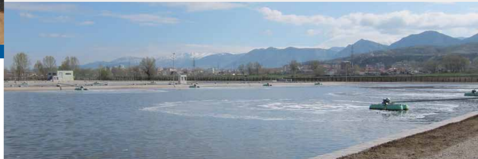
Belüftete Klärteichanlage in Albanien für 70.000 EW
