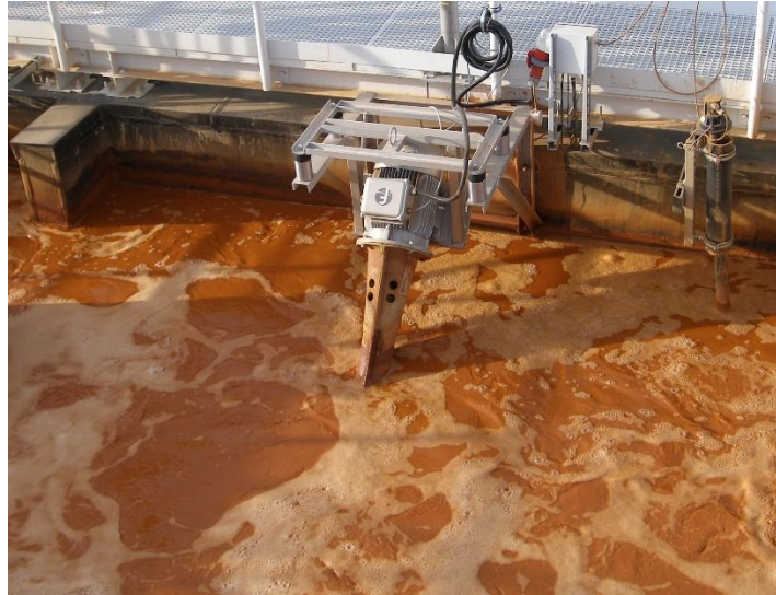
Wasserbehandlungsanlage "Ronneburg" (Wismut)
