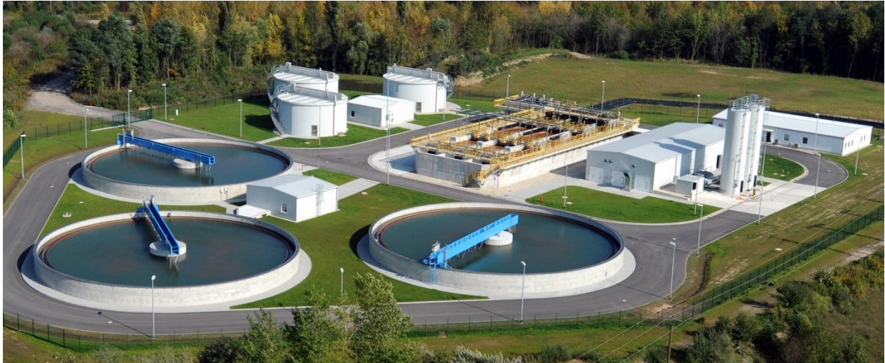
Grubenwasserreinigungsanlage "Schleenhain" (MIBRAG)
