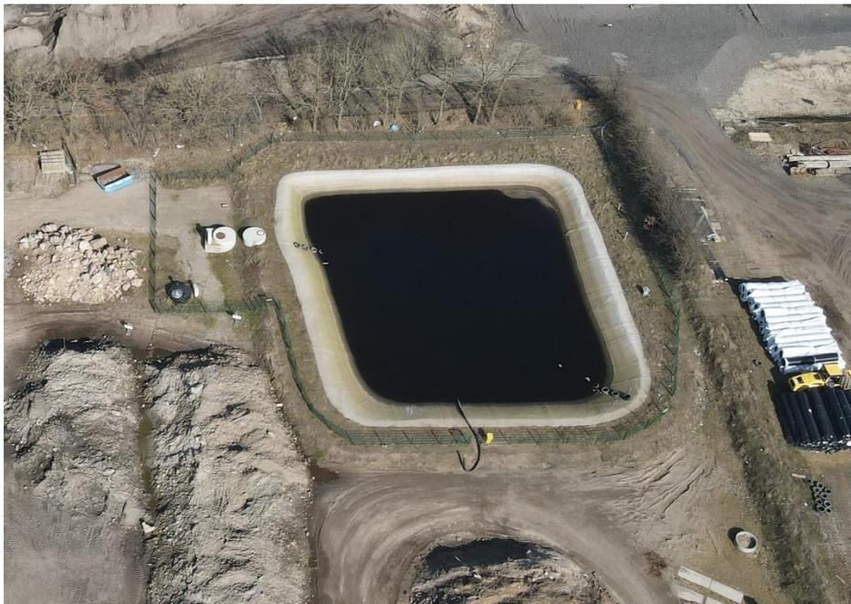
Das Becken hat die Maße Länge x Breite = 30 m x 25 m und ein Nutzvolumen von ca. 2000 m<sup>3</sup>. Es wurde ein FUCHS OxyStar Belüfter OS 4.0 mit einer Motornennleistung von 3,0 kW auf einem stabilen Schwimmer installiert und mit einer Haltestange und Abspannseilen an Betonfundamenten am Teichrand befestigt.
