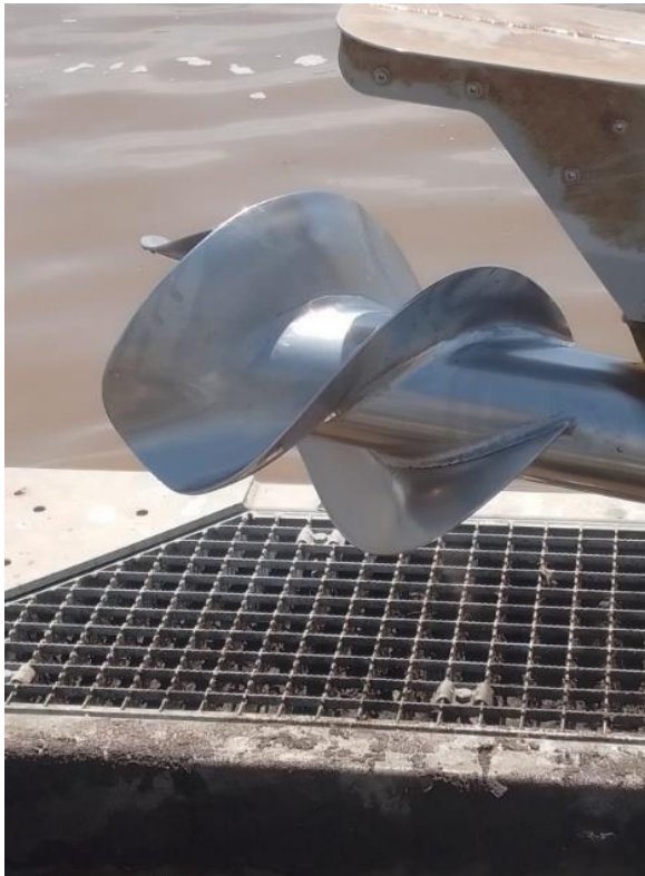
Fig. 6 Condición del rotor libre de materiales enredados o fibrosos, sin anomalías en el eje hueco. Conjunto en óptimo estado mecánico y de funcionamiento. Detalle de faena mantenimiento en plataforma.
