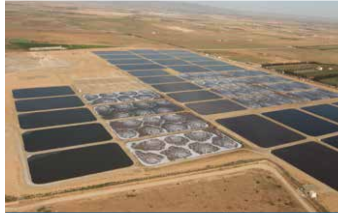
Extenso sistema de lagunas aireadas para aguas residuales con aireadores OxyStar® (Marruecos)
