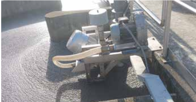
DualStar Belüfter mit Aufhängung an einer Maschinenbrücke
