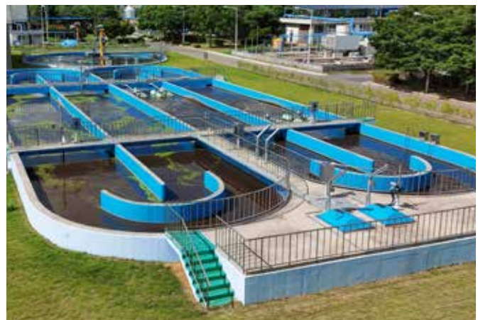
Oxidationsgraben einer kommunalen Kläranlage (Korea)
