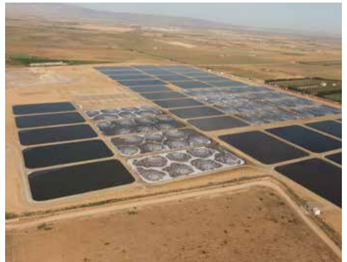
Belüftete Klärteichanlage mit OxyStar® Belüftern (Marokko)
