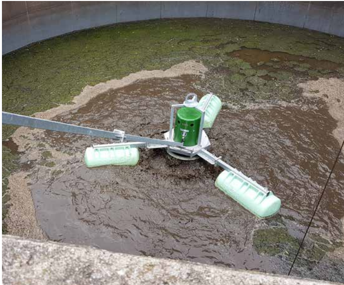
Aérateur CX-S monté sur flotteurs
