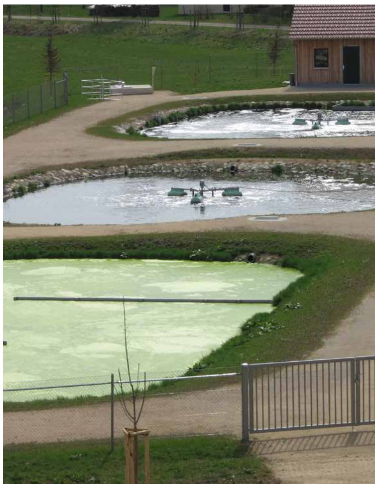
Aérateur Centrox dans une petite station d'épuration communale (Allemagne)
