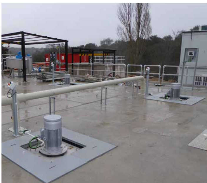
Aérateur Centrox CX-S avec aspiration de mousse dans un réacteur couvert
